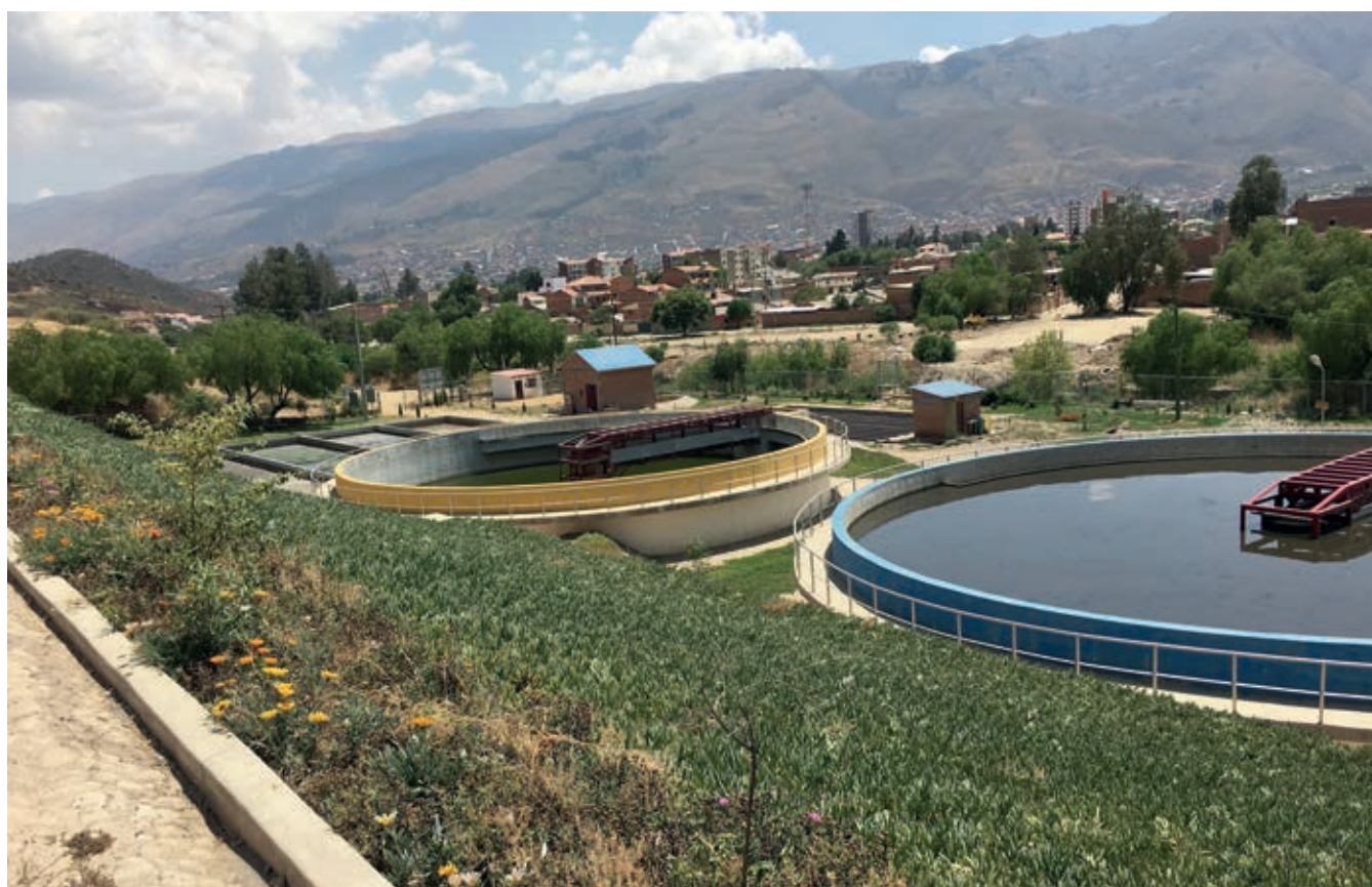
Sedimentadores Secundarios PTAR EMAPAS (Sacaba)
