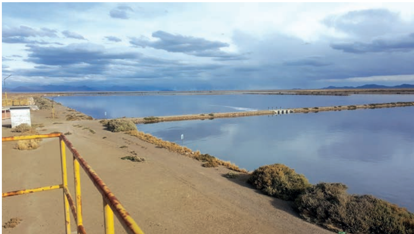
Lagunas Facultativas PTAR SeLA (Oruro)
